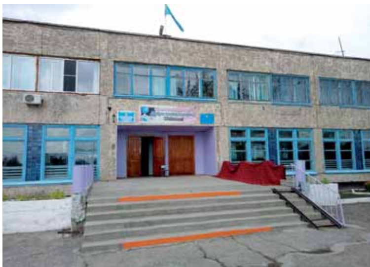
Первоначально ремонт кровли школы оценивался в сумму более 47 млн тенге, а замена канализации – около 43 млн тенге. Однако при утверждении бюджета города на 2018 год сумма, предназначенная для капитального ремонта в СОШ №34, не была заложена. Фото автора
