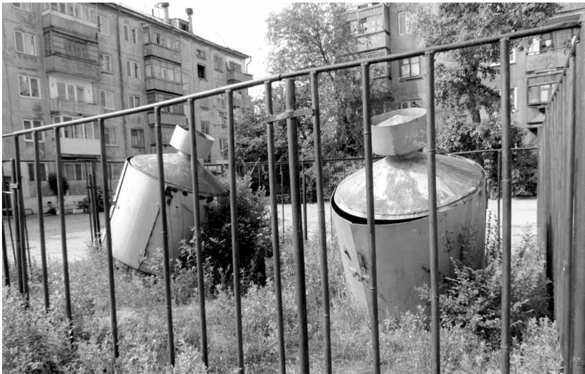
Большинство газораспределительных установок во дворах областного центра разобрано и сломано. Из общего числа ГРУ лишь 18 являются действующими, это 12%. Фото автора
