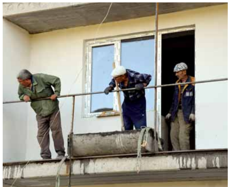
Строительство первого многоэтажного дома – своеобразный экзамен, который покажет, не разучились ли в моногороде строить жилье. Фото автора
