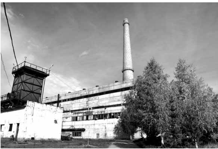
Чтобы переоборудовать районную котельную в мини-ТЭЦ, необходимо 2,6 млрд тенге. Фото автора
